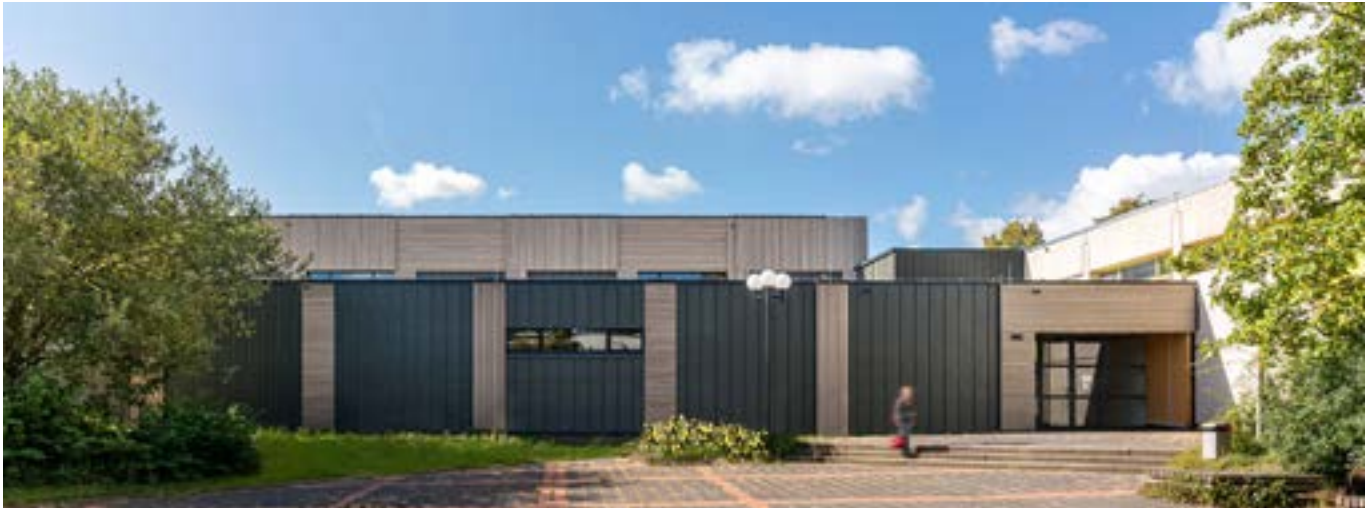
Die seriell sanierte Turnhalle in Wachtberg
