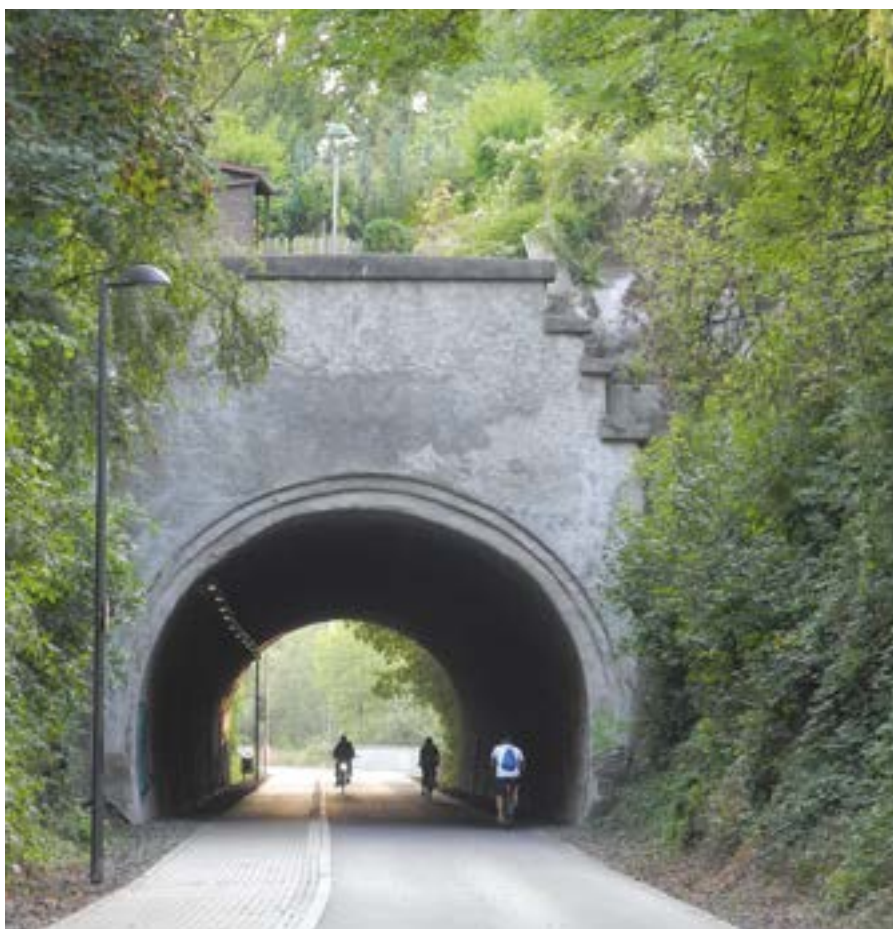
Fatloh-Tunnel der Wuppertaler Nordbahntrasse Foto: Im Fokus / Wikimedia Commons [CC BY-SA 4.0]
