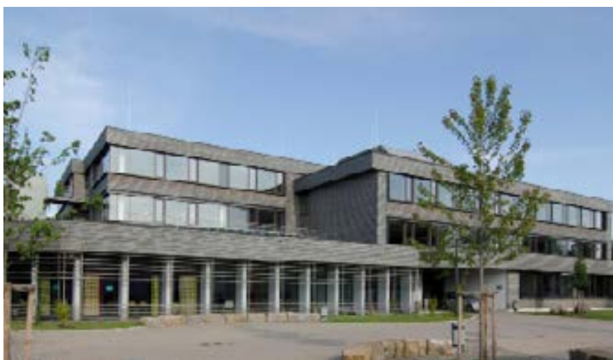
Die Realschule Buchloe wurde 2009 während der Sommerferien mit vorgefertigten Holzmodulen seriell saniert. Der Primärenergiebedarf reduzierte sich von 211 kWh/m 2 a auf 35 kWh/m 2 a.
