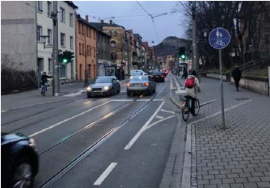
Mangel: „Auf Höhe der Haltestelle (...) müssen Radfahrer und Fußgänger unverhältnismäßig den Bordstein teilen. (...) Des Weiteren ist der Schutzstreifen an bestimmten Stellen zu schmal.“ Antwort: „Der gegenwärtige Zustand wird bleiben und ist rechtmäßig.“ Foto: M. Wilde
